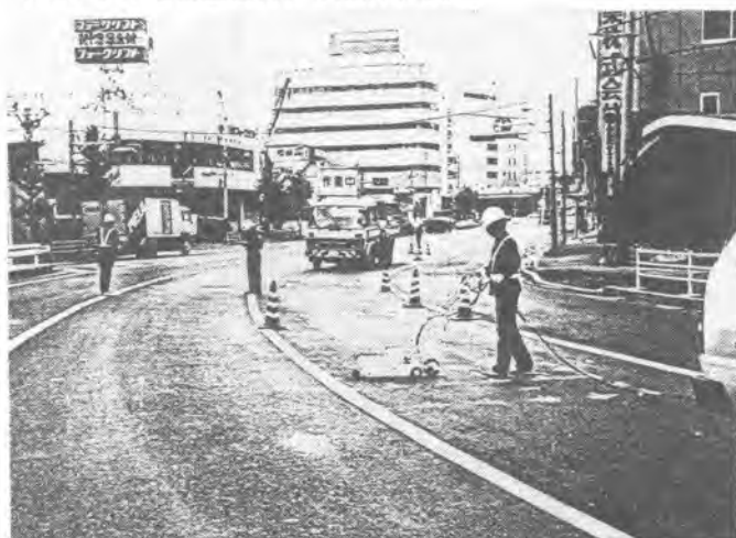
写真-3 メッシュ調査作業状況
