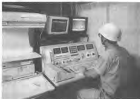
写真-1 運転操作監視の状況
