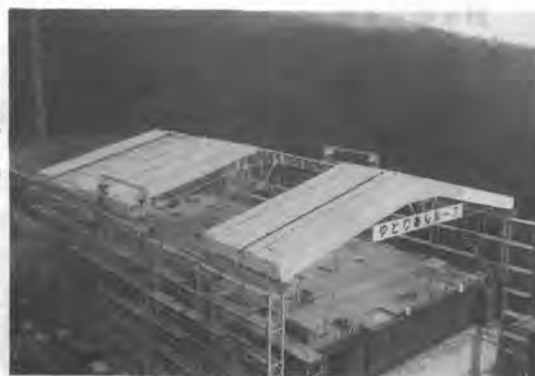
写真2. 通常施工時(屋根一部開)
