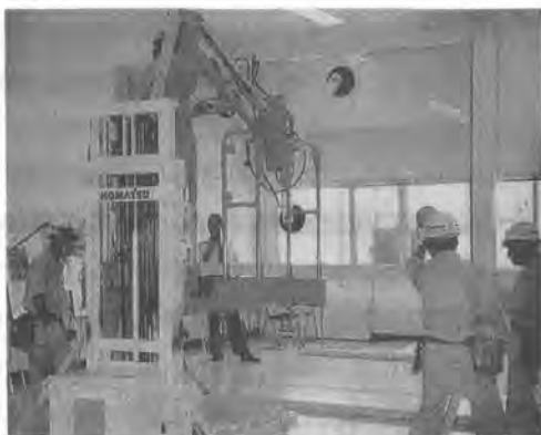
写真-6 ガラスの施工
