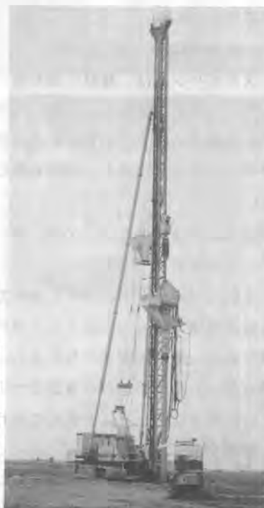
写真-1 関空で稼働中の開発1号機
