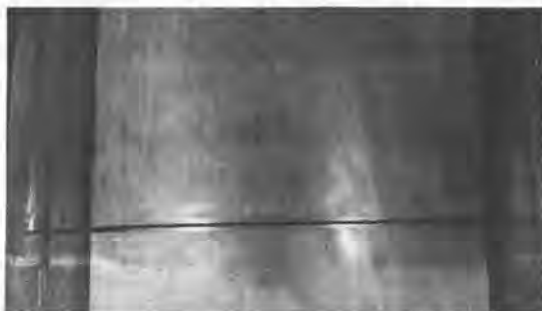
写真2. 水中切断後の鋼管矢板
