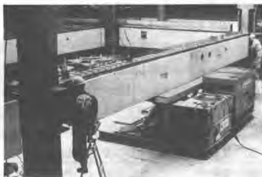
ATBによるPC梁取付作業状況
