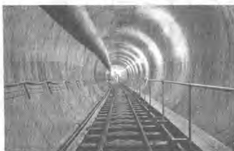
写真-4 支保工のない区間
