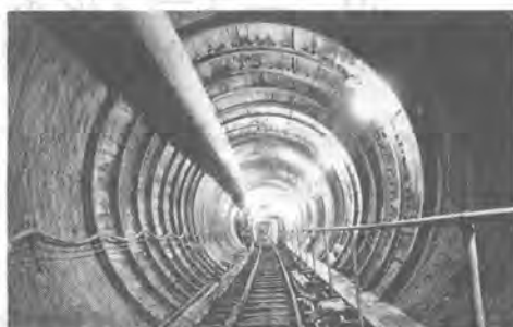
写真-5 支保工区間
