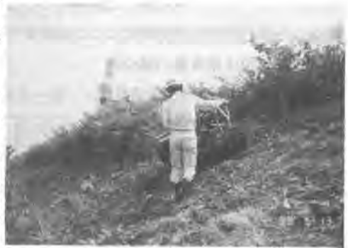
写真-1 ハンドガイド式による作業
