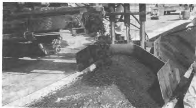
路肩舗装に（ベルトコンベアタイプ）
