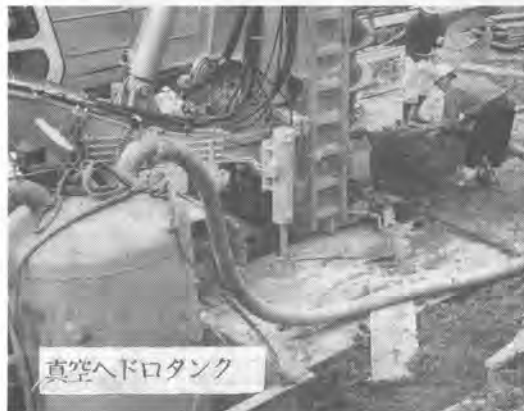
写真-2 オーガ削孔残土の泥土搬送
