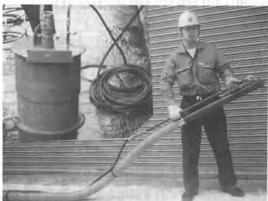
写真-8 高吸水性樹脂添加ポンプと混合ノズル
