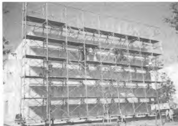
写真－3 現場実証試験状況
