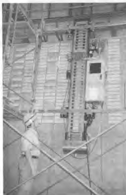
写真-1 タイル張りロボット実用機
