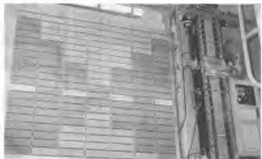
写真-2 タイル施工仕上げ面
