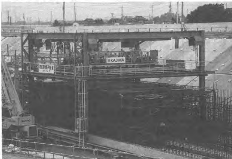
写真-1 鉄筋自動配列装置全景
