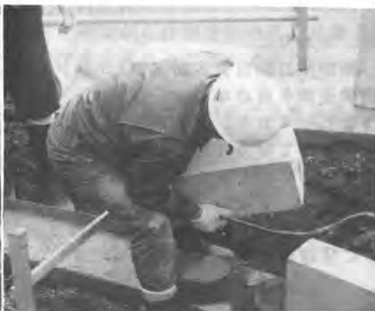
写真-2 人力による据付施工状況
