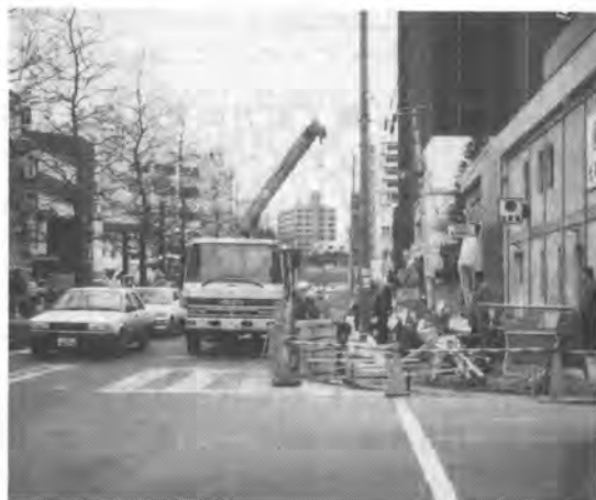
写真-1 車線規制による施工状況
