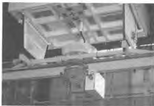
【写真-1 開発機全景】
