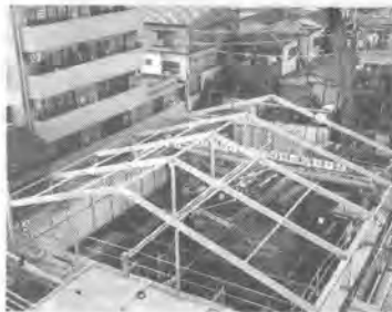
写真-6 組立状況
