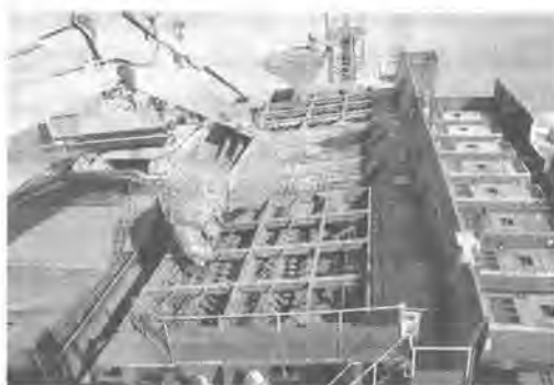
写真-2 バックホウによる揚土状況
