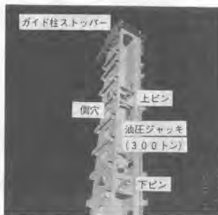
写真-6 ガイド柱の構成
