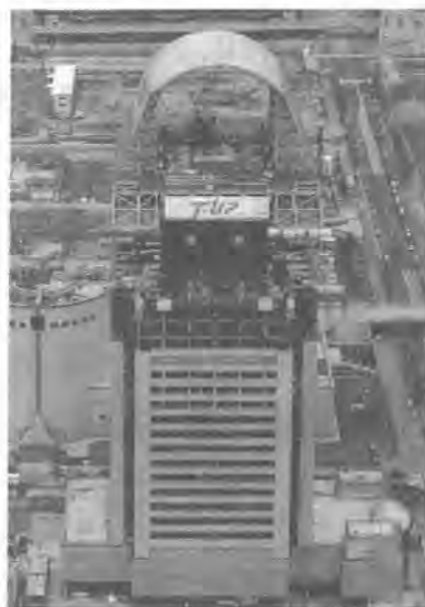
写真-1 T-UP工法の施工状況
