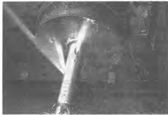
写真-4 面板洗浄システム
