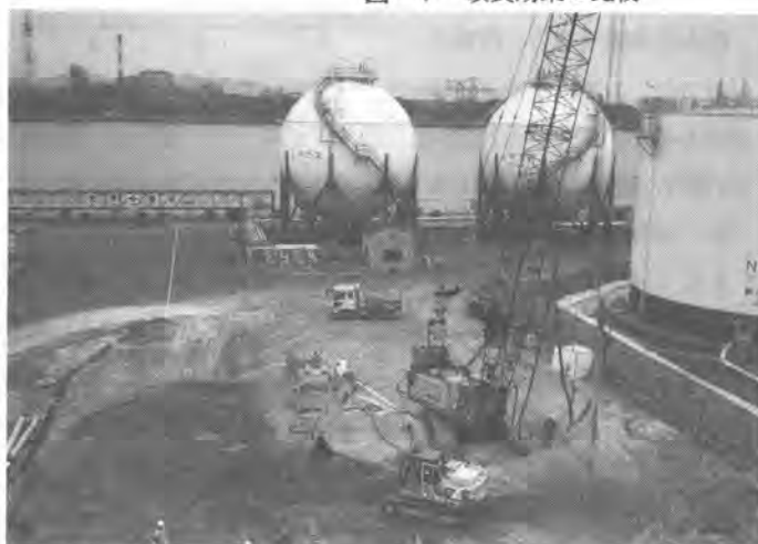
写真-1 施工状況
