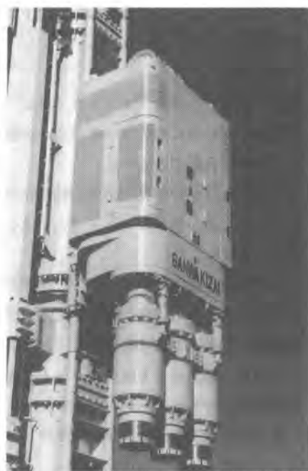
写真-2 ロッド自動連結装置
