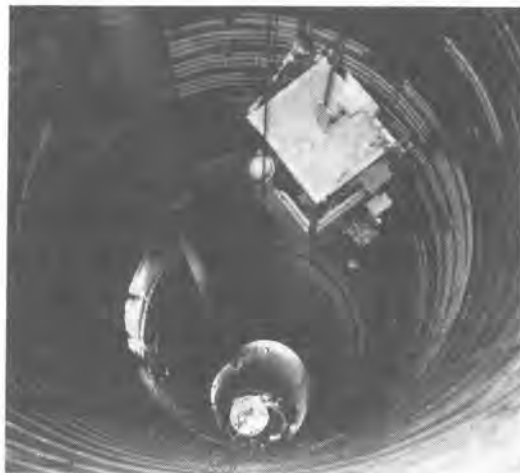
写真 6 深礎工用ゴンドラ使用状況
