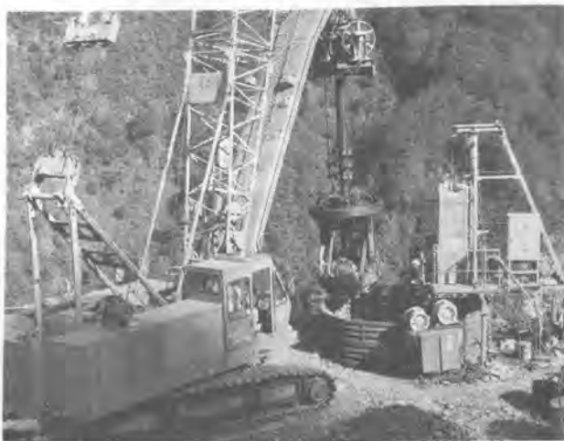
写真-3 HSED機による掘削状況
