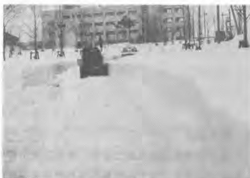
写真-3 水平自動制御による仕上がり状態
