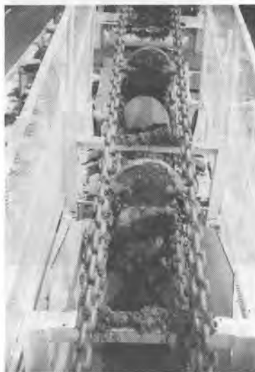
写真-4 土砂排土状況
