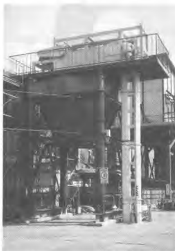
写真-5 装置地上部
