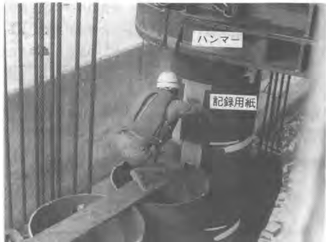
写真-1 現状のリバウンド測定状況
