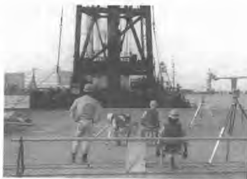
写真-3 レベル計測状況
