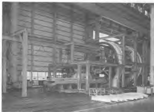
写真-1 実証実験装置全景
