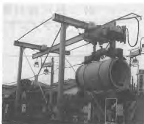
写真-1 ヒューム管搬入状況
