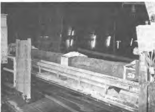
写真-3 立坑の最下部の状況
