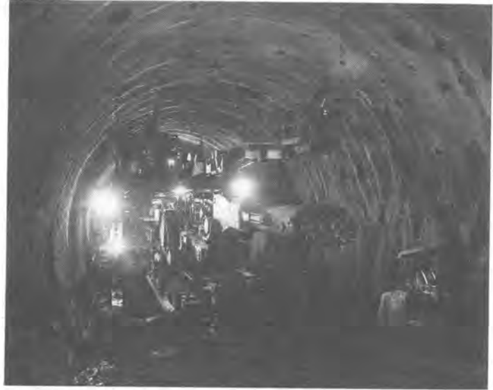
写真-2 現場施工状況
