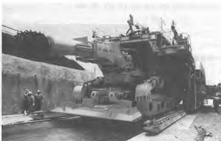
写真-1 自由断面掘削機+多機能型作業構台
