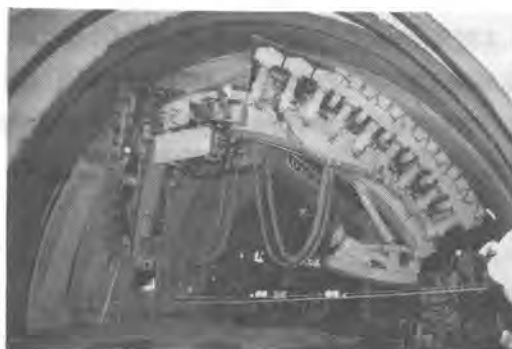
写真-2 K-N T L 工法機施工状況
