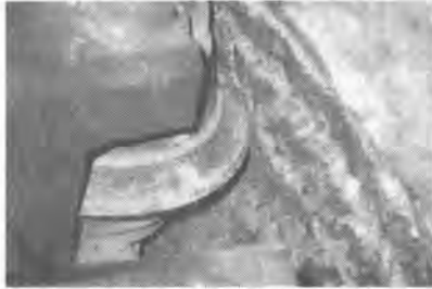
写真-3. 破碎状況
