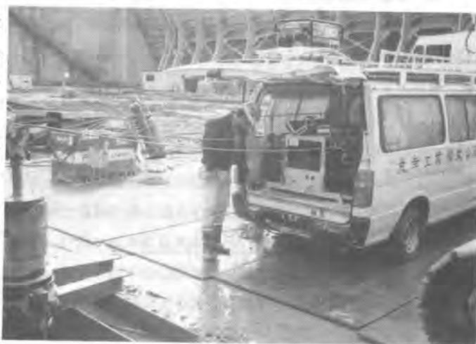
写真-2 精度管理システムによる計測状況
