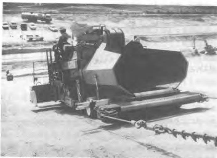
写真-1 ダムフェーシング工事での施工状況 (レーザ誘導方式自動操向)
