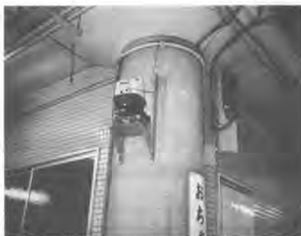
写真-1. スタッフ・レベル取付状態
