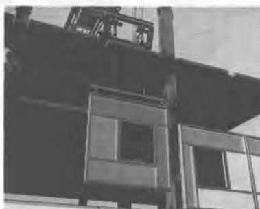
写真-8 外壁の取付
