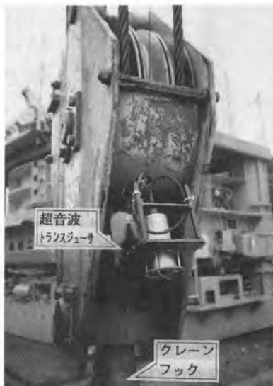
写真4 超音波制御取付け状況
