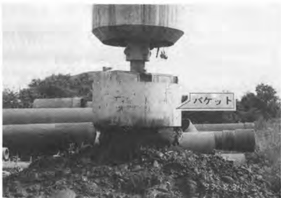
写真3 バケット作動状況 (無線操作)
