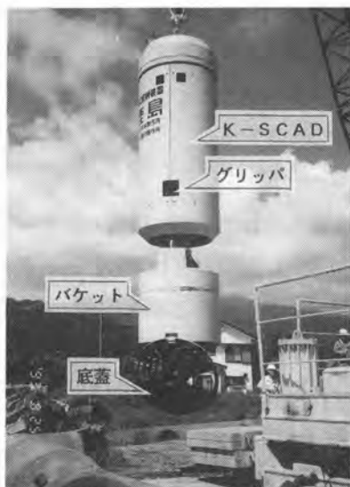
写真3 バケット作動状況 (無線操作)
