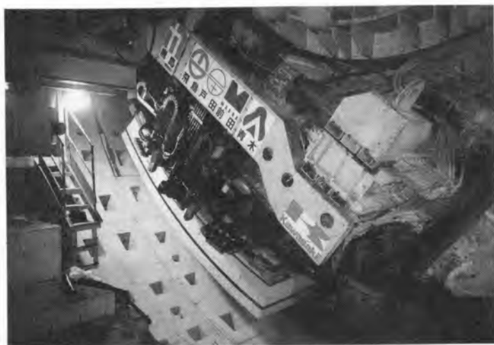
写真-2 セグメント組立状況
