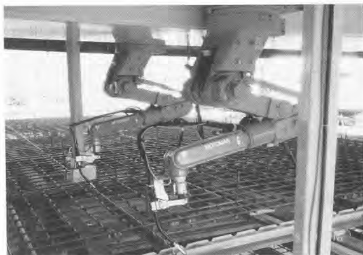
写真-1 「鉄筋籠自動溶接ロボットシステム」 多関節ロボット部
