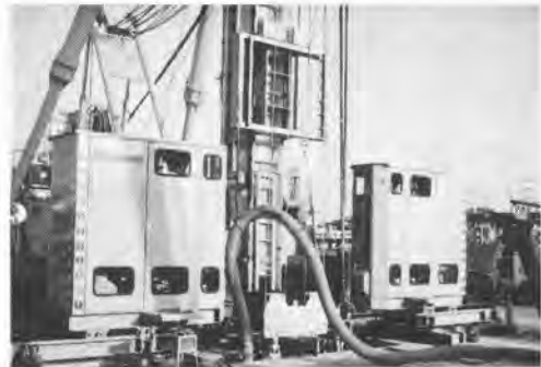
写真-3：高精度位置管理システム使用状況
