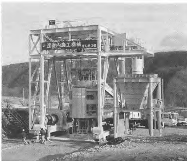
写真-1 試験施工
