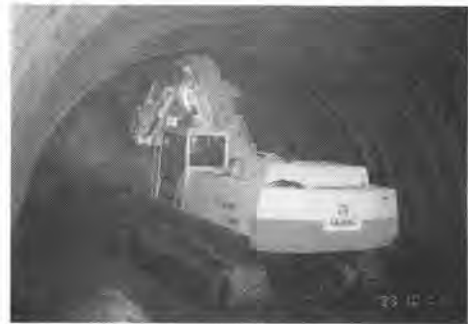
写真-2 施工状況
