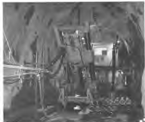
写真-1 機械設置状況
