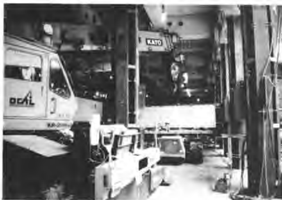
写真2 低床式重量物運搬機の実工事風景
