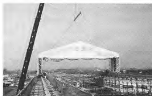
写真5 屋根据付け
