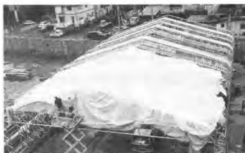
写真3 膜材の取付け
