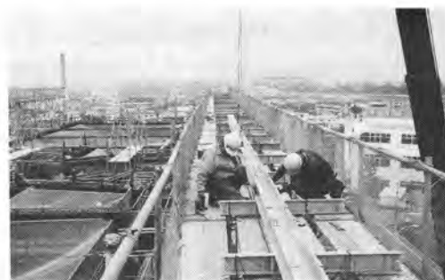
写真4 走行用レール架台の設置
