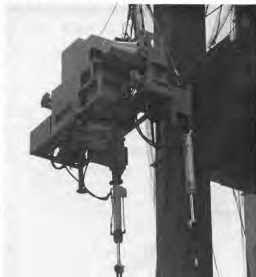
写真-1 施工状況
