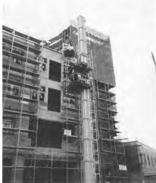
写真-1 クレーン全景
