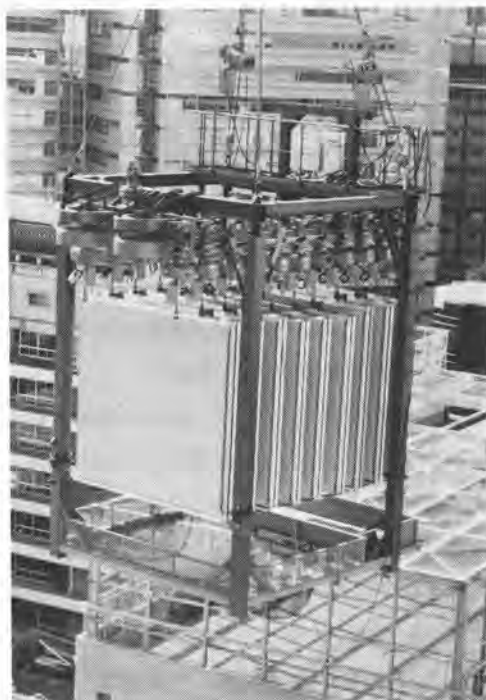
写真-1 本システム揚重状況
