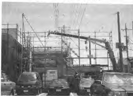
写真-4 超高圧線作業
