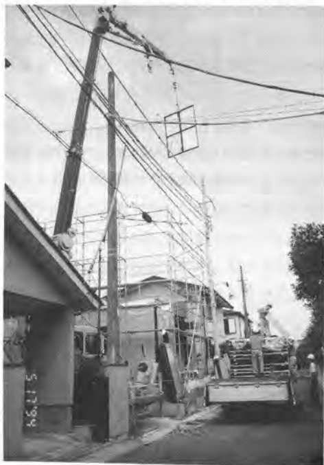
写真-2 電線越え施工
