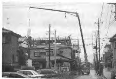
写真-3 3F建て施工
