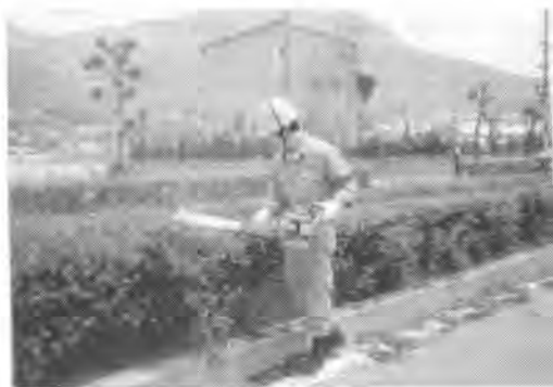
写真-1 人力施工状況
