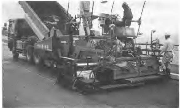
写真-2. 施工状況
